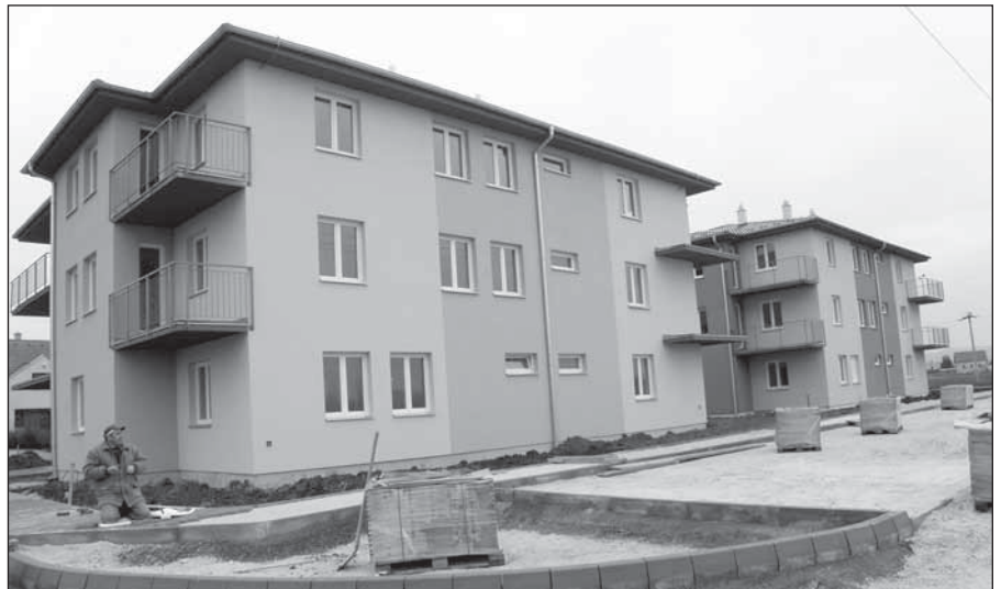
■ Práce na dokončení nájomných bytov finišujú.
