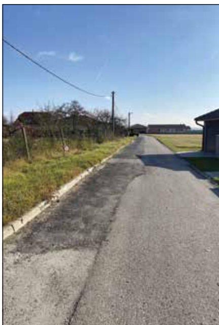
■ Čiastočná oprava ciest frézovaným asfaltom
