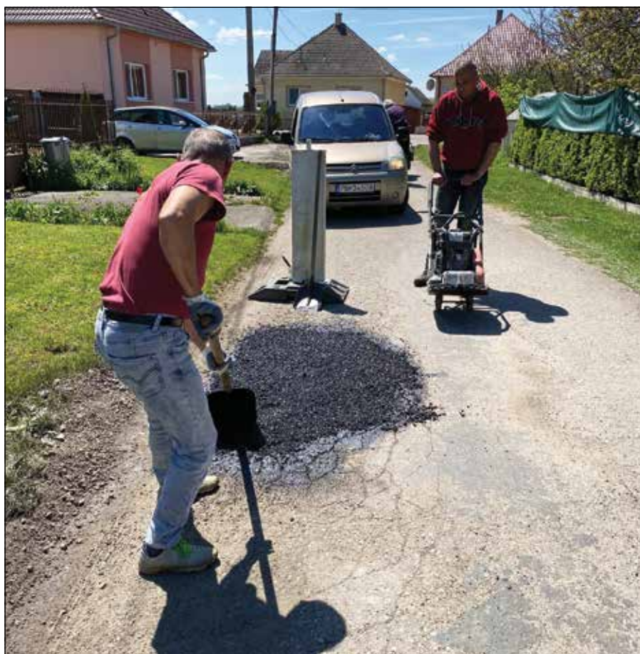
■ Oprava výtlkov na ceste
