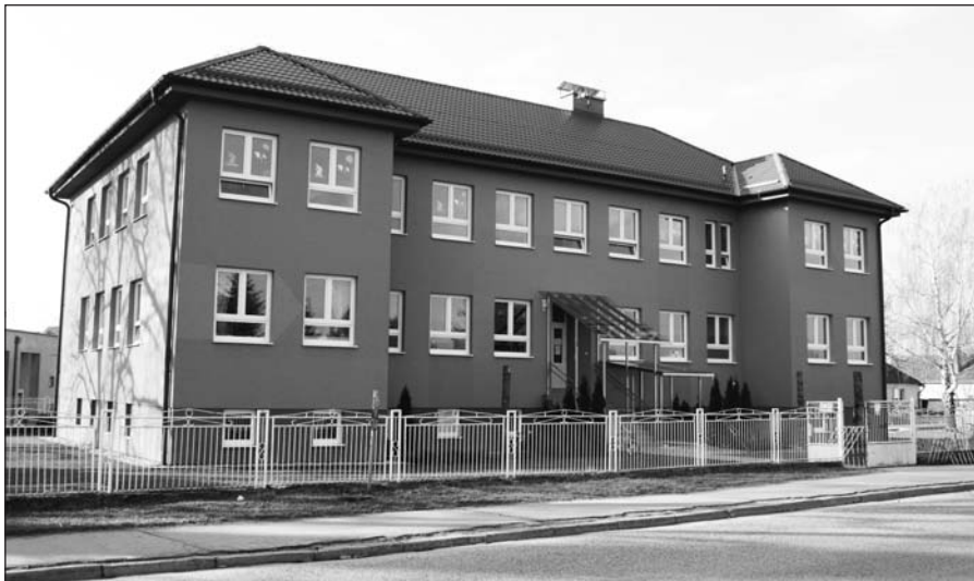
■ Zrekonštruovaný objekt poskytuje zázemie všetkým vzdelávacím zariadeniam. Foto: J. Tkáč
