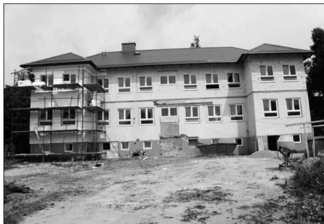
■ Stará materská škola počas nadstavby a rekonštrukcie. Foto: L. Pavlech
