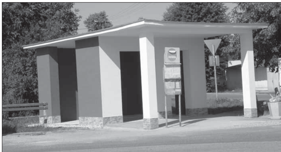
■ Autobusová zastávka v Malom Orvišti dostala po rekonštrukcii novú podobu vďaka konateľovi spoločnosti Prowin Jánovi Zenkayovi. Ešte by mohol vylepšiť tabuľu dopravný podnik...
