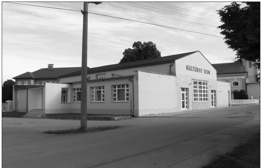
■ Na kultúrnom dome sme komplexne obnovili celú strechu.
