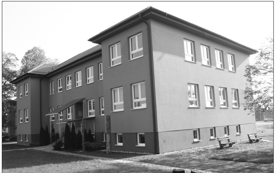
■ Zrekonštruovaná nadstavená budova materskej školy od decembra bude opäť slúžiť školám.
