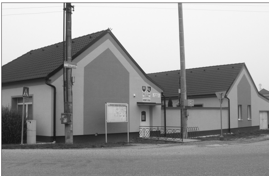
■ Zrekonštruovaný obecný úrad.
