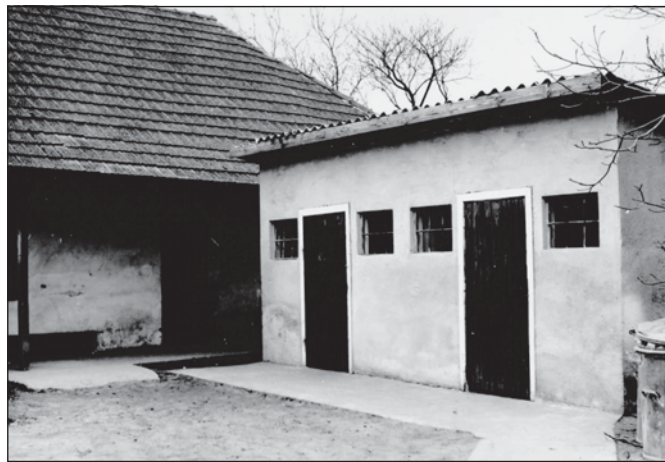
■ Žiacke hygienické zariadenia – latríny, ktoré patrili k starej budove ZŠ
