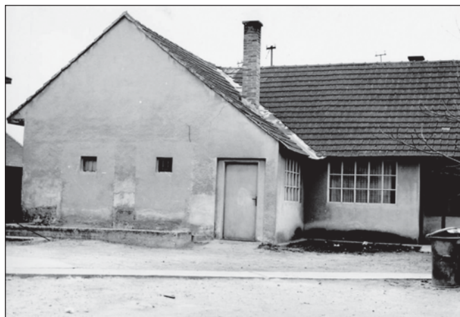
■ Stará budova materskej školy vo dvore základnej školy, ktorá bola zbúraná
