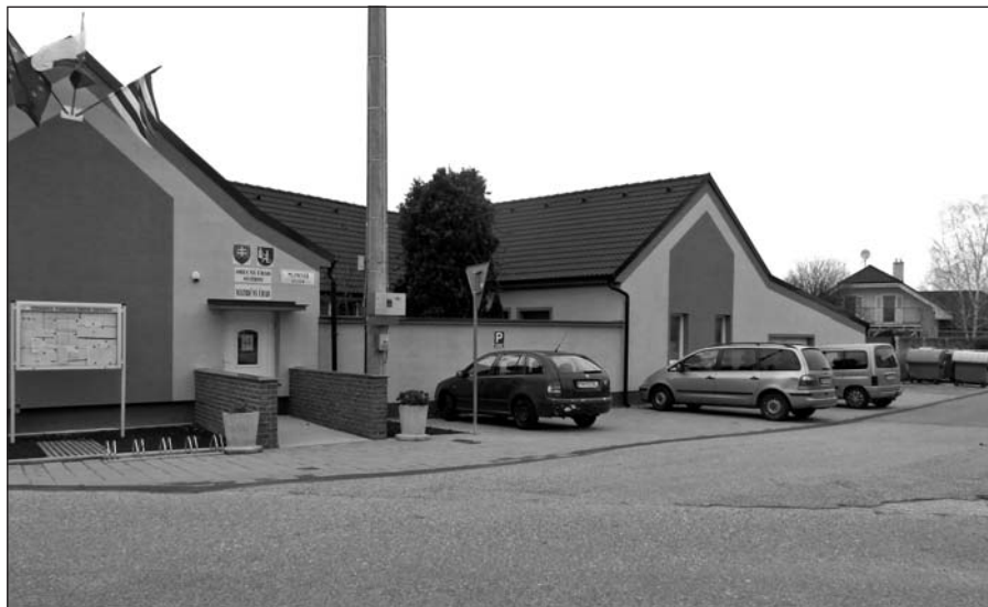
■ Aj parkovisko pred obecným úradom má teraz žiaducu dôstojnú podobu
