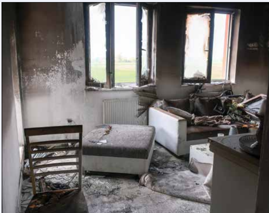
■ V byte, v ktorom požiar vypukol, bolo potrebné urobiť kompletnú rekonštrukciu Foto: Jozef Tkáč
